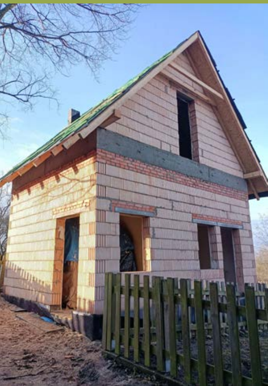
Nowy budynek kotłowni w Owczarach w trakcie budowy. Fot. Magdalena Makowska
